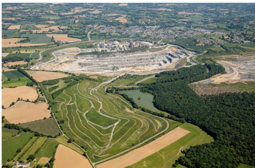
Vue aérienne après réalisation
